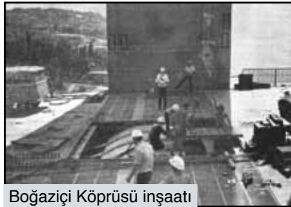
Boğaziçi Köprüsü inşaatı
